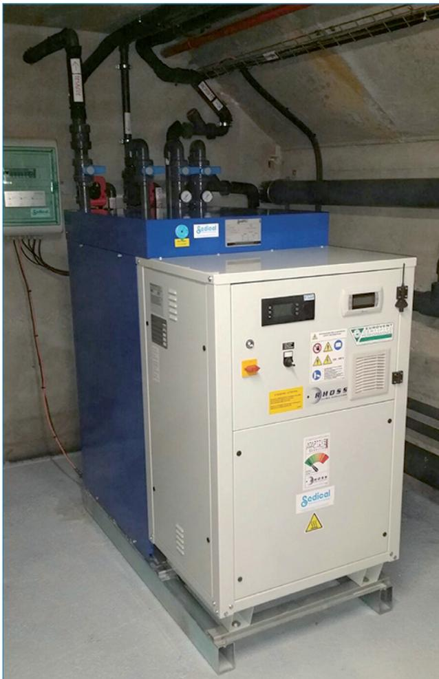
Equipo de recuperación de alta eficiencia del calor del agua de renovación de piscinas.
